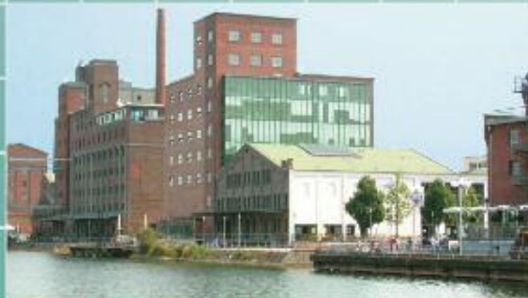
■ Umbau Werhahnmühle zum Kindermuseum „Atlantis“
