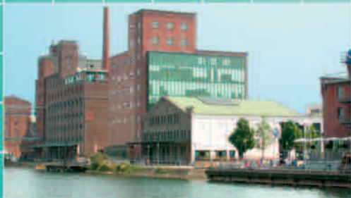
■ Umbau Werhahnmühle zum Kindermuseum „Atlantis“
