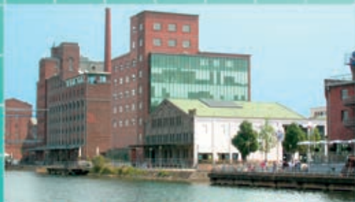
■ Umbau Werhahnsmühle zum Kindermuseum „Atlantis“
