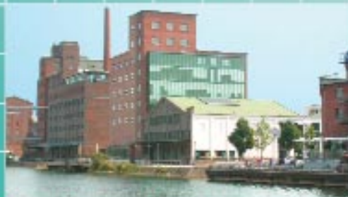
■ Umbau Werhahnmühle zum Kindermuseum „Atlantis“
