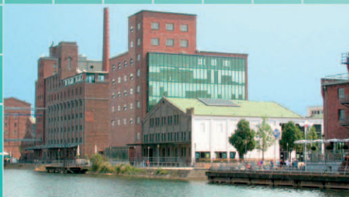
■ Umbau Werhahnmühle zum Kindermuseum „Atlantis“
